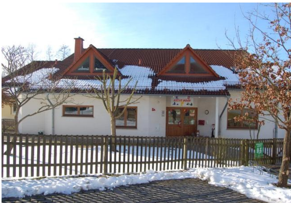
Blick auf den Kindergarten „Arche Noah“.
