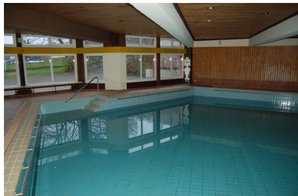
Das Hallenbad im BGH wird derzeit vom Trägerverein Friedensdorf e.V. saniert.
