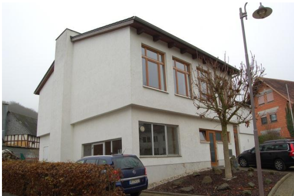
Blick auf das Dorfgemeinschaftshaus.
